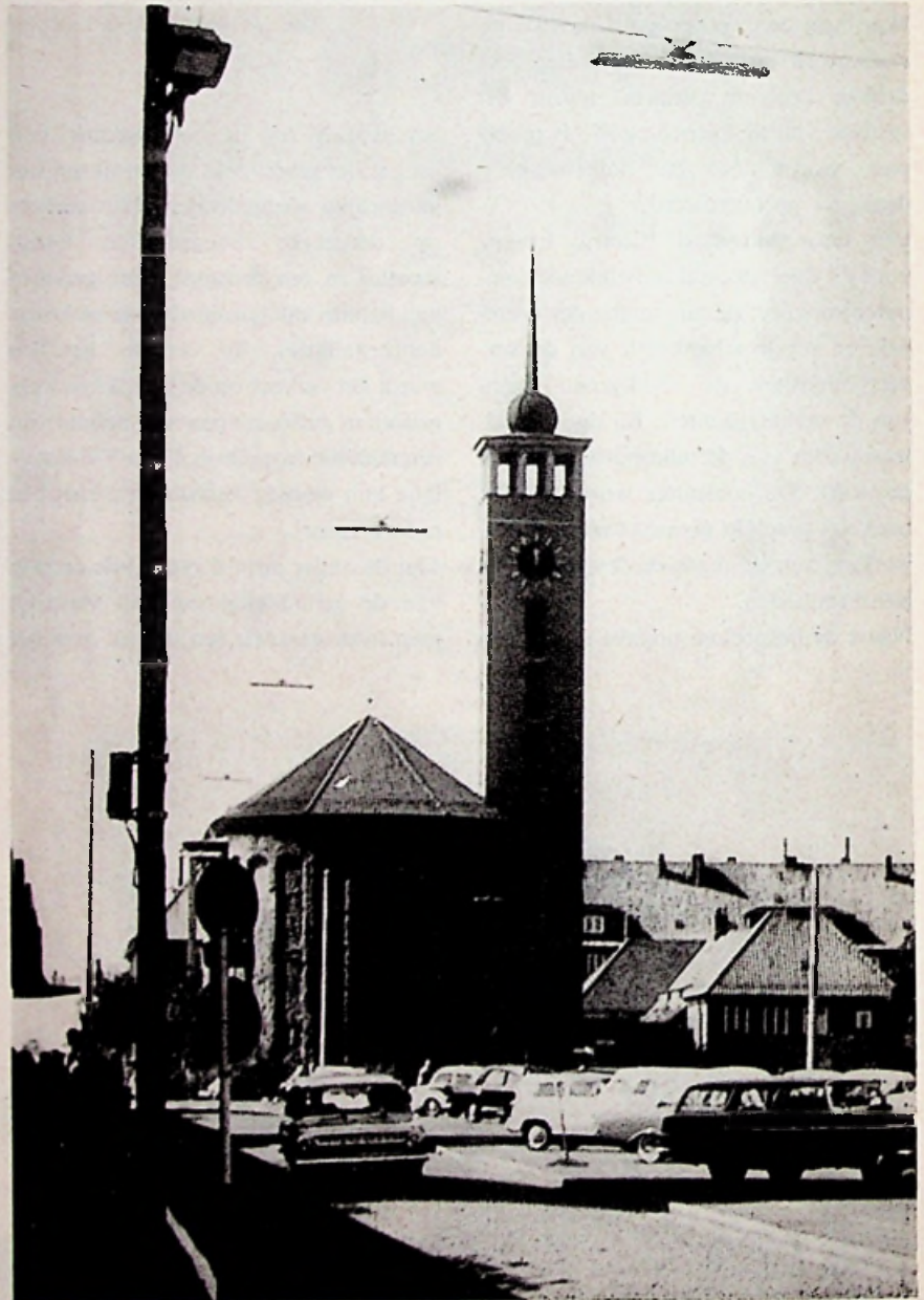
Een druk kruispunt wordt gecontroleerd door een radar-detector, geheel boven-in de mast; de teleenheid vindt u op het midden. Het geheel lijkt ons met het oog op de toekomst van het wegverkeer een interessant experiment. De apparatuur wordt hier dus niet meer uitsluitend gebruikt om verkeerszondaars te schaken; integendeel.
